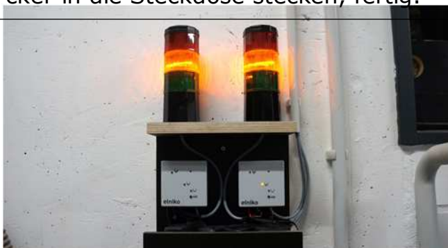
Plug&Play Modul2 - Nur noch die Sen- sorenleitung anschließen und den Ste- cker in die Steckdose stecken, fertig.
