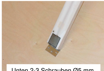
Unten 2-3 Schrauben Ø5 mm
