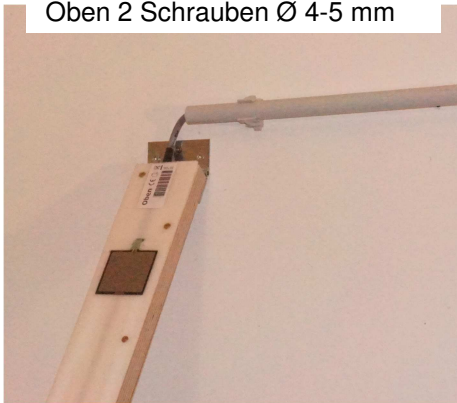
Oben 2 Schrauben Ø 4-5 mm
